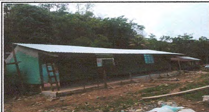
Foto1: Colocación de láminas.
