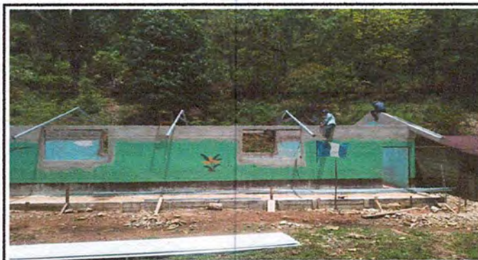
Foto 4: Collocación de costaneras.
