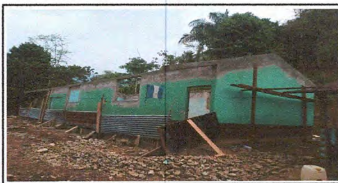
Foto 6: Colocación de piso.
