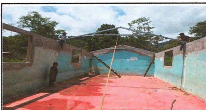
Foto 5: Inicio de la colocación de costaneras.
